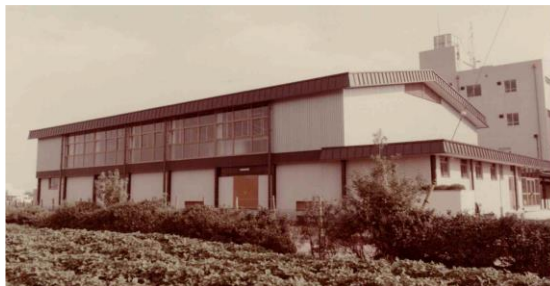
完成当時の体育館
